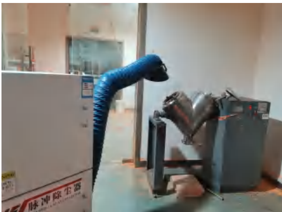
氮化物成品混料间
