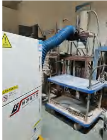
铝酸盐混料间（集气罩+滤筒除尘器）
