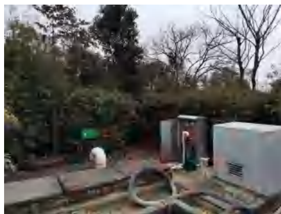
污水站（格栅+初沉池+调节池+A/O 生物池+二沉池处理工艺）
